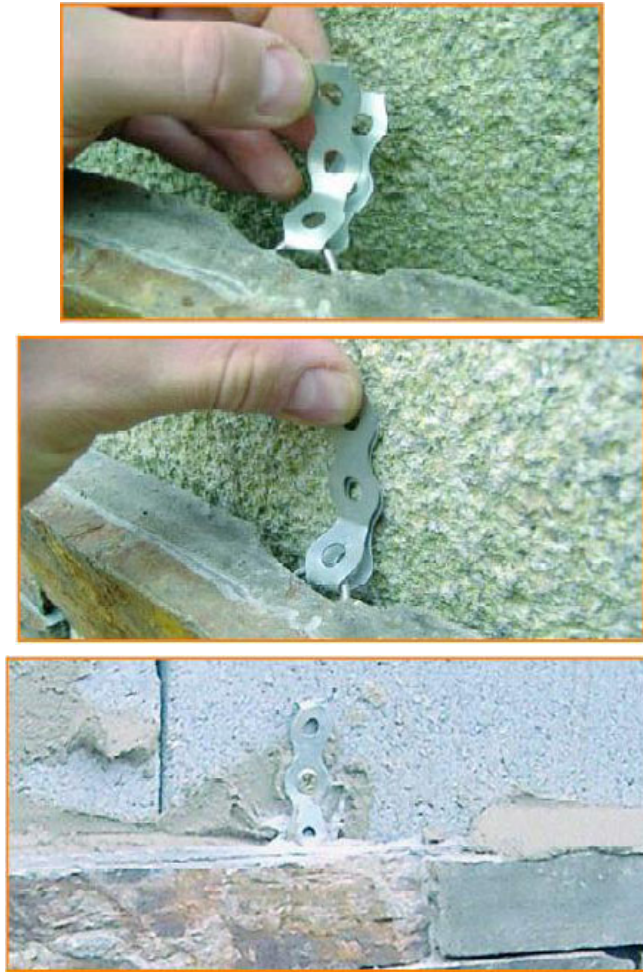
Figure 6– STONEPANEL SKY : mise en œuvre de l'élément de sécurité
