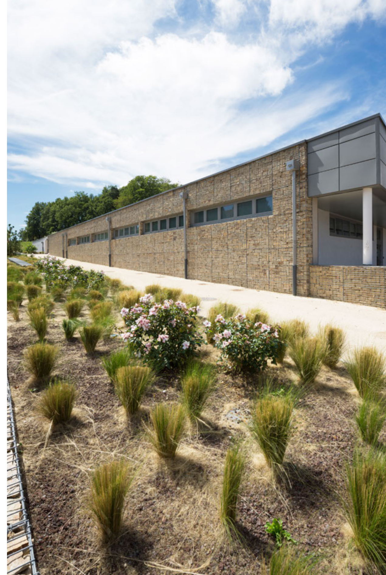
CENTRE AQUATIQUE SOUTERRAINE Sostranien, Francia Arquitecto: Moinard Blanchet Associés Architectes en colaboración con Spirale Material: gaviones de gneis Saint-Yrieix
