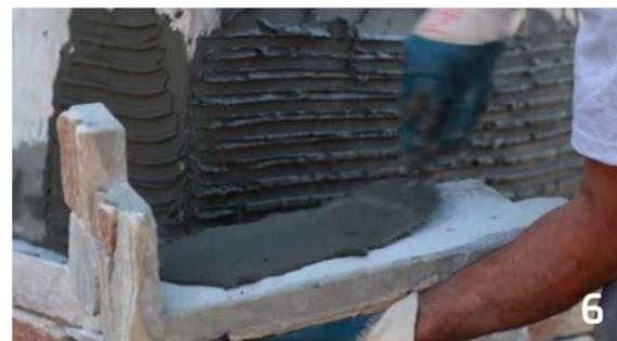
Aplica también en la parte trasera del panel una capa gruesa de mortero-cola y distribuirlo de manera horizontal usando una llana dentada de 6-7 mm. El mortero usado debe ser C2 o C2-S1/S2 en interiores y C2-S1/S2 para exteriores.
