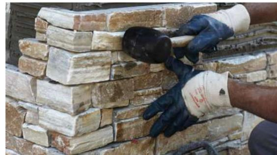
Después de fijar el panel y atornillarlo al muro, debe golpearse con un mazo de goma para colocarlo y evitar las burbujas de aire entre el panel y el muro y asegurar la unión.
