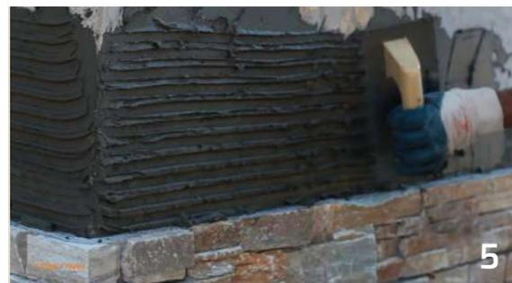
Con la llana dentada, debe aplicar horizontalmente una capa gruesa y lisa de 6-7 mm de mortero-cola. Para que la primera fila quede nivelada, la instalación debe realizarse sobre un listón de metal o sobre un pequeño perfil en L de acero inoxidable. El listón se podrá retirar una vez seque el mortero-cola y el perfil de acero inoxidable quedará integrado en la instalación.
