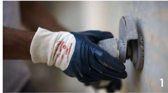
Los muros deben estar limpios y libres de películas de polvo, suciedad, aceite, pintura, etc. Cualquier fisura o agujero debe rellenarse con lechada de cemento. El muro soportará un peso por encima de los 100-110 kg/m<sup>2</sup>. El sistema debe instalarse únicamente cuando no haya signos de humedad sobre la superficie, excepto aquellos causados por la condensación.
