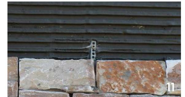
Siga el mismo procedimiento con el resto de paneles de la fila y, para que el anclaje mecánico esté completamente cubierto y no interfiera con la instalación de los paneles.
