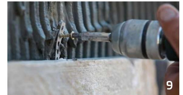
Inserte el tornillo a través de la banda y fíjelo en el muro. El STONEPANEL® se ajustará firmemente.
