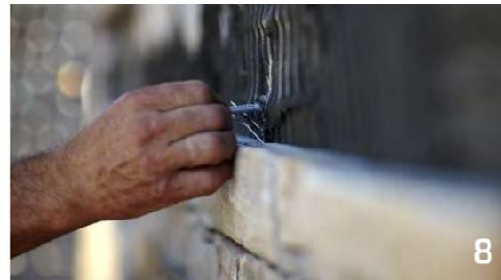
Cada panel requiere una fijación mecánica. Perfore los agujeros para colocar los tornillos de acero inoxidable e inserte los tacos en el muro como ayudas para el anclaje.
